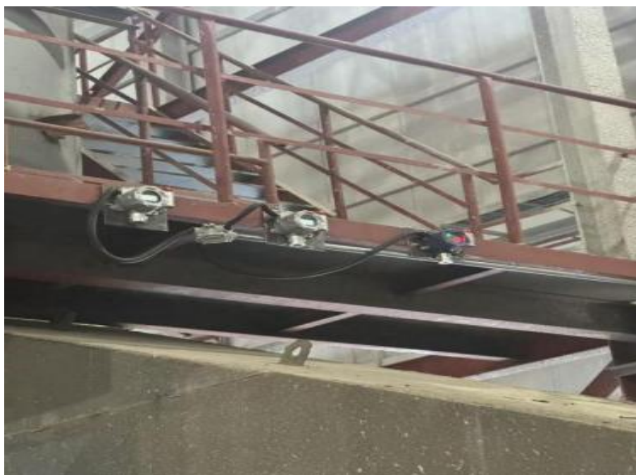
图 8.6-1 隔油池有毒气体检查探头整改
